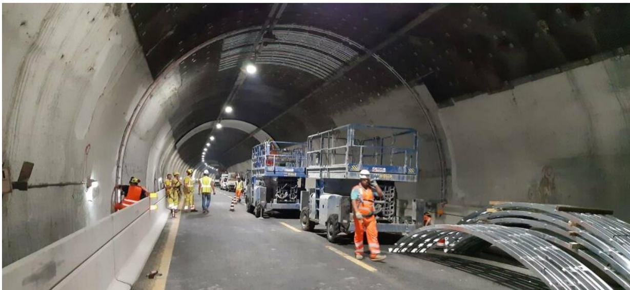
La finalizzazione dell'installazione di 95 centine nel tunnel non consente, infatti, di effettuare i lavori a transito aperto, in completa sicurezza. Le attività sono state portate avanti finora e proseguiranno successivamente in modalità notturna, e in base all'avanzamento dei prossimi giorni si potrà valutare una possibile compressione dei tempi di realizzazione.
