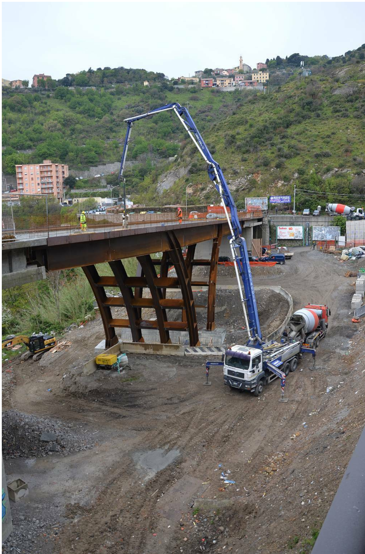
Genova. Sono terminate mercoledì le prove di carico del Ponte Don Acciai, nel quartiere del Lagaccio, la cui riapertura, a senso unico di marcia a salire da via Bari a via Napoli, è
