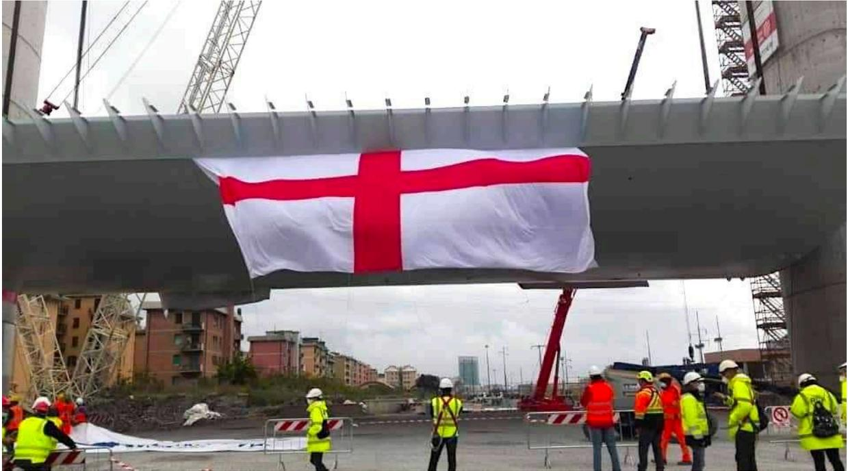
**Genova.** E' iniziato poco dopo le 14 il varo dell'ultima campata delle 19 del nuovo viadotto sul Polcevera. Le operazioni procederanno lentamente, l'impalcato - 44 metri per circa 800 tonnellate - salirà 5 metri all'ora grazie all'ausilio degli strand jack, montati sulle pile 11 e 12.
