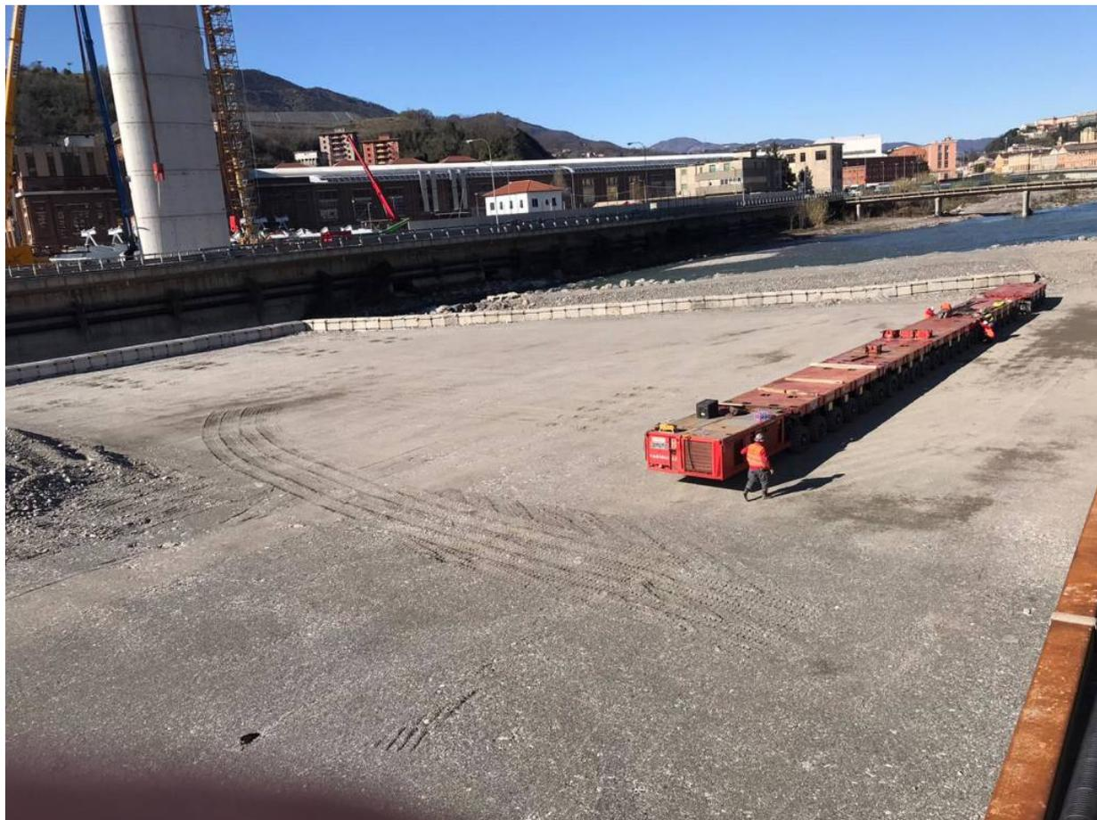
**Nel Polcevera è stata realizzata una sorta di isola artificiale** che la pioggia degli scorsi giorni aveva portato via. In queste ore sono in corso le operazioni in alveo per approntare la struttura di sostegno per il sollevamento della campata. In cantiere, contemporaneamente, è in corso la fase di pre “jackup”, che consiste nel predisporre il sistema di sollevamento al di sotto dell’impalcato: servirà, una volta ultimato, a sollevarlo per portarlo alla quota di via 30 Giugno.
