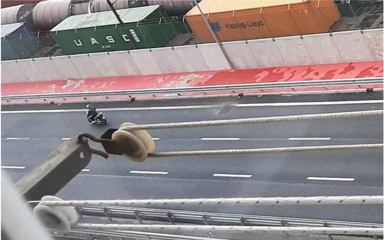
**Genova.** Lo strato di vernice rossa che ha coperto il grigio del cemento lungo lo spazio ciclabile nel nuovo allestimento di Lungomare Canepa è già scrostato e ammalorato.
