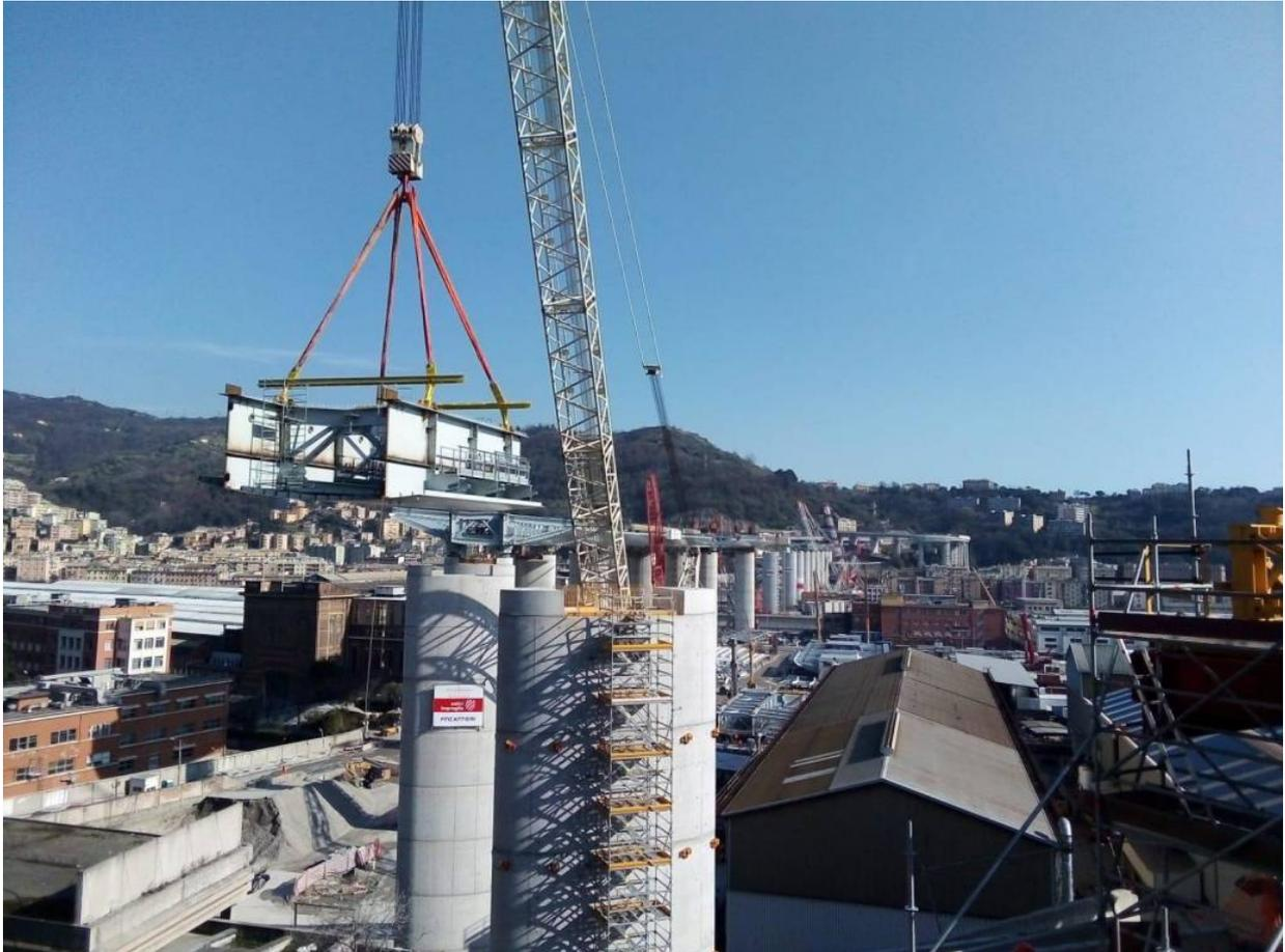
**Genova.** Nuovo passo avanti nella realizzazione del nuovo viadotto sul Polcevera. Si è conclusa nel primo pomeriggio di oggi l'operazione di varo del secondo concio della spalla di Ponente del nuovo Viadotto Polcevera.
