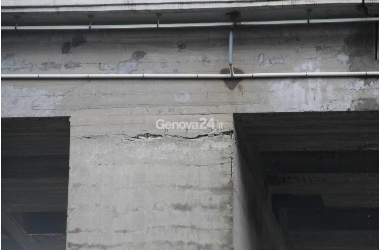
**Genova.** Infiltrazioni, ammaloramenti dei piloni, e **alcune crepe sulle teste dei piloni che fanno paura**. Ma del ponte, ad oggi, non sono noti i **dettagli sul suo stato di salute** mancando la valutazione sulla sua condizione.
