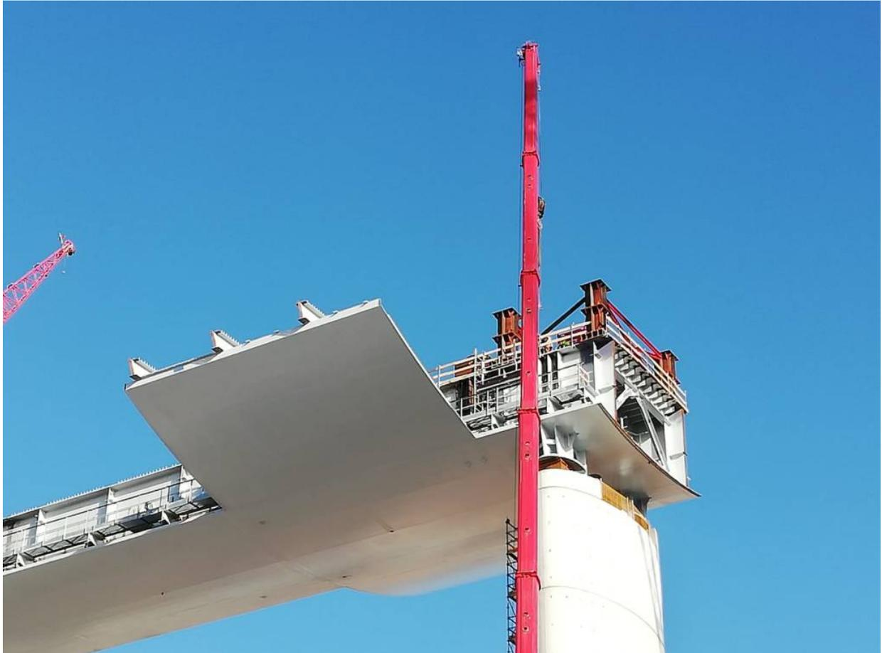
**Genova.** Chiusura in vista per via 30 Giugno, nei prossimi giorni, in previsione del prossimo varo del concio della pila 9. Il concio è una parte in acciaio da 100 tonnellate che si fisserà sulla pila e servirà per collegare l'impalcato.
