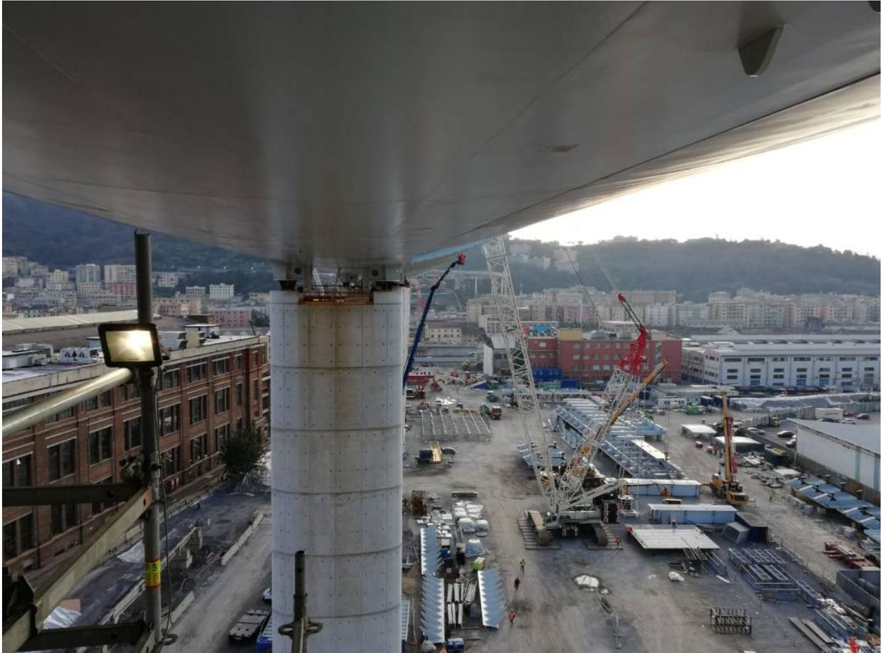
**Genova.** Mentre si attende il varo del primo maxi concio da 100 metri del nuovo ponte sul Polcevera (sarà necessario chiudere via 30 Giugno ma anche la ferrovia), si prepara l'innalzamento di un'altra campata da 50 metri, quella tra le pile 13 e 14.
