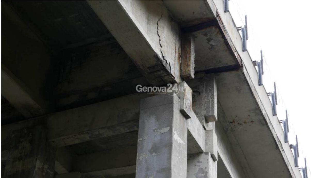
**Genova.** Con una valutazione del grado di ammaloramento schizzata le scorse settimane, a seguito di una nuova ispezione, **a quota 70 punti**, il viadotto **rio Coppetta** è il grande malato della A7, oggi "sotto i ferri", ma che per anni sembra essere stato abbandonato a se stesso.
