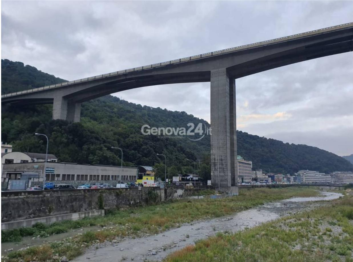
**Genova.** “Le anomalie segnalate sulle prime pile di ponente e alla base delle pile dove sono presenti erosioni della scarpata, con fondazioni particolarmente profonde” del viadotto Bisagno, “non hanno influenza sul comportamento della struttura né presentano la possibilità che tale influenza si verifichi a breve o medio termine, come confermato anche dai controlli straordinari attivati dalla direzione di tronco di Genova, a valle del tragico evento del 14 agosto 2018”.
