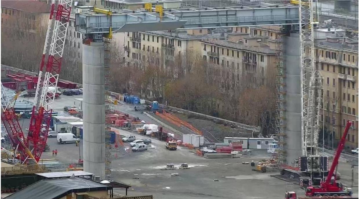
**Genova.** È in corso dalle 10 di stamattina il **varo del primo impalcato sul lato di Levante** del nuovo ponte sul Polcevera, quello tra le pile 14 e 15. Per motivi di sicurezza scatta la **temporanea chiusura di via Fillak** riaperta solo poche settimane fa con lo spostamento delle aree di cantiere.
