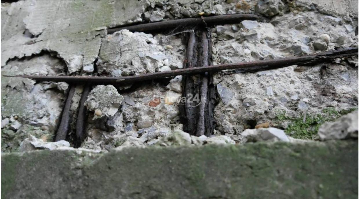
**Genova.** I problemi al viadotto Sori, sulla autostrada A12 Genova-Livorno, riguarderebbero non solo l'impalcato e l'interno dei piloni ma anche la base dei due piloni iniziali dell'infrastruttura e i traversi, dove sarebbe stata rilevata una corrosione esterna.
