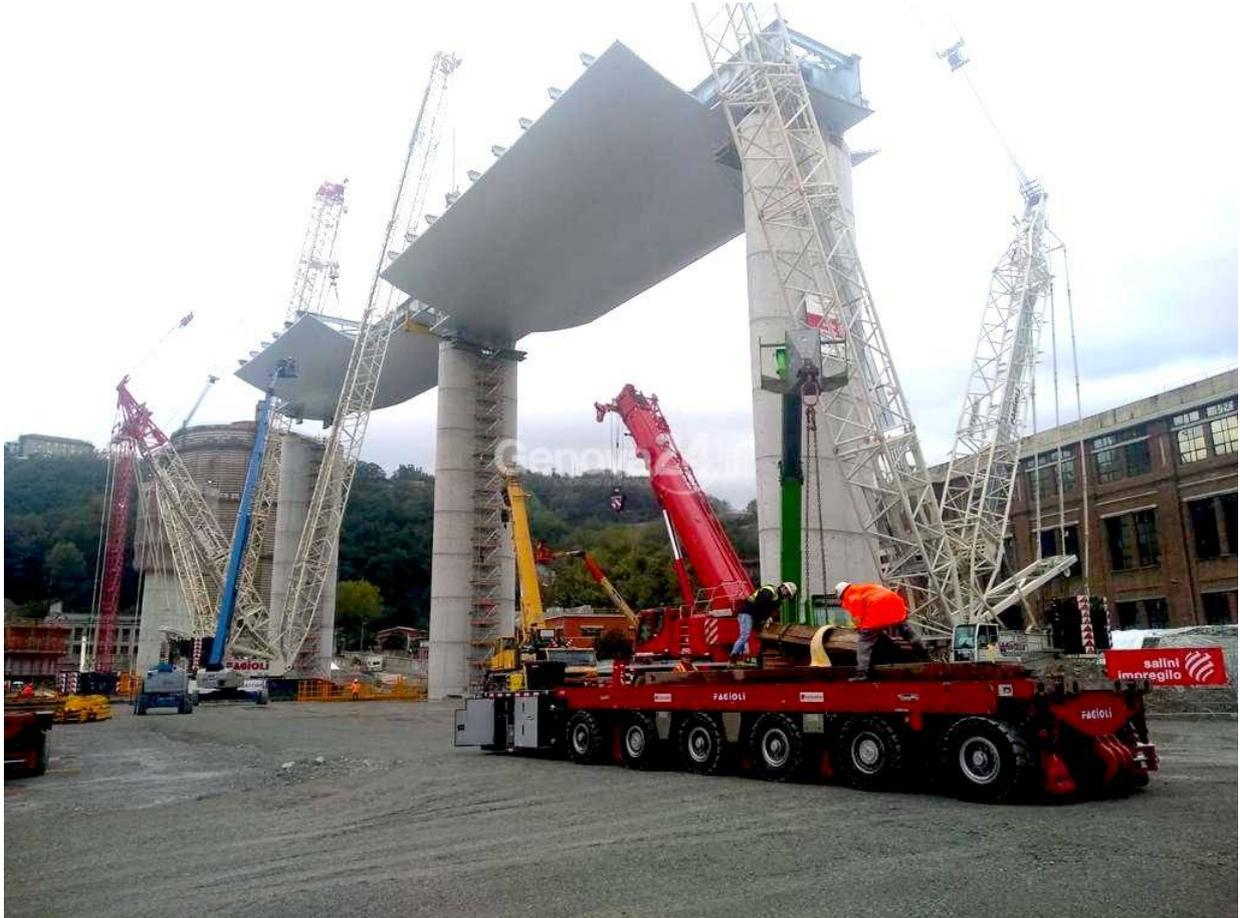
**Genova.** Sono iniziate nel primo pomeriggio, e mentre scriviamo si sono già quasi concluse, le operazioni di sollevamento e varo in quota, a 40 metri d'altezza, del secondo impalcato del nuovo ponte Per Genova.
