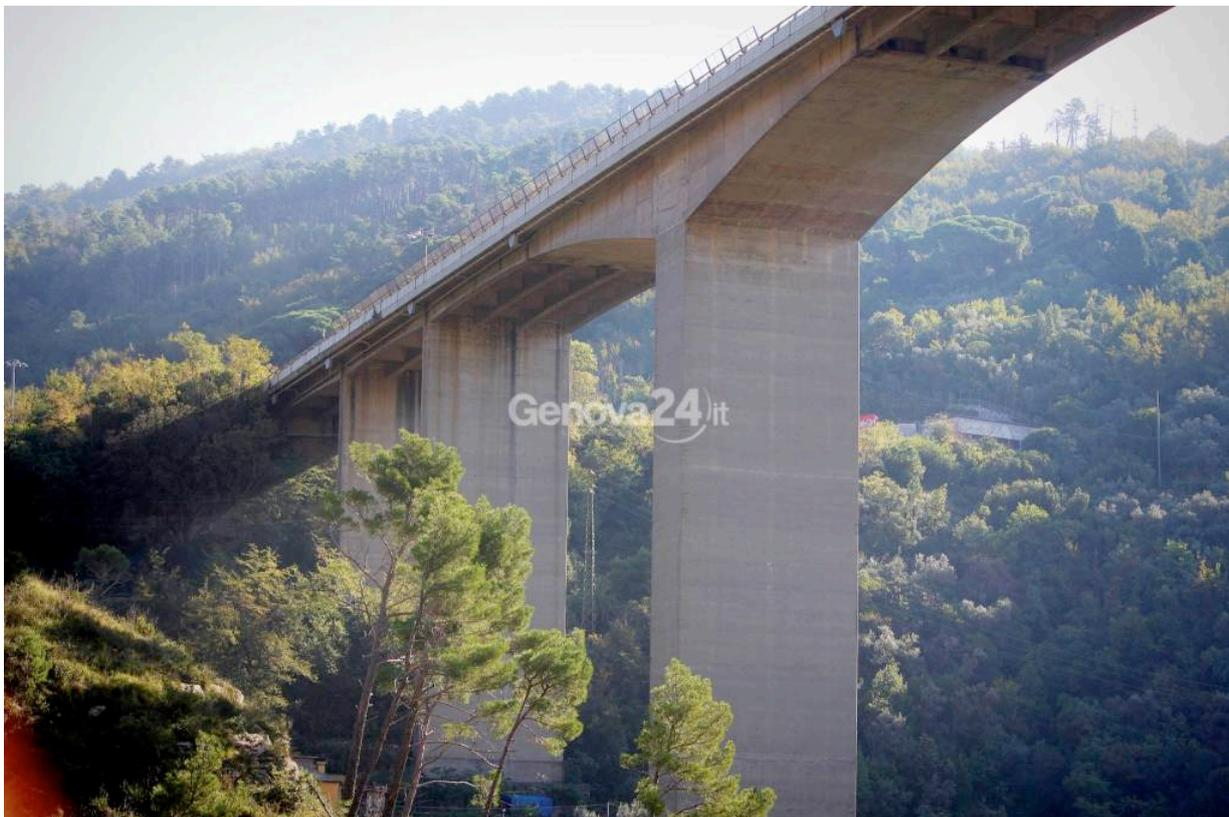
**Il Sori e il Nervi sono praticamente identici:** alti un centinaio di metri, hanno le tre pile maggiori larghe 6 metri e profonde 14,55. Ognuna di esse ha due sbalzi di 35 m, uno per lato; i due sbalzi adiacenti sono collegati da una trave prefabbricata lunga 30 metri. Prefabbricate sono anche le travi delle campate di accesso. L'impalcato, unico per entrambe le carreggiate, è largo 19,10 metri. Differiscono solamente per il fatto che il Nervi ha una campata d'accesso in meno.
