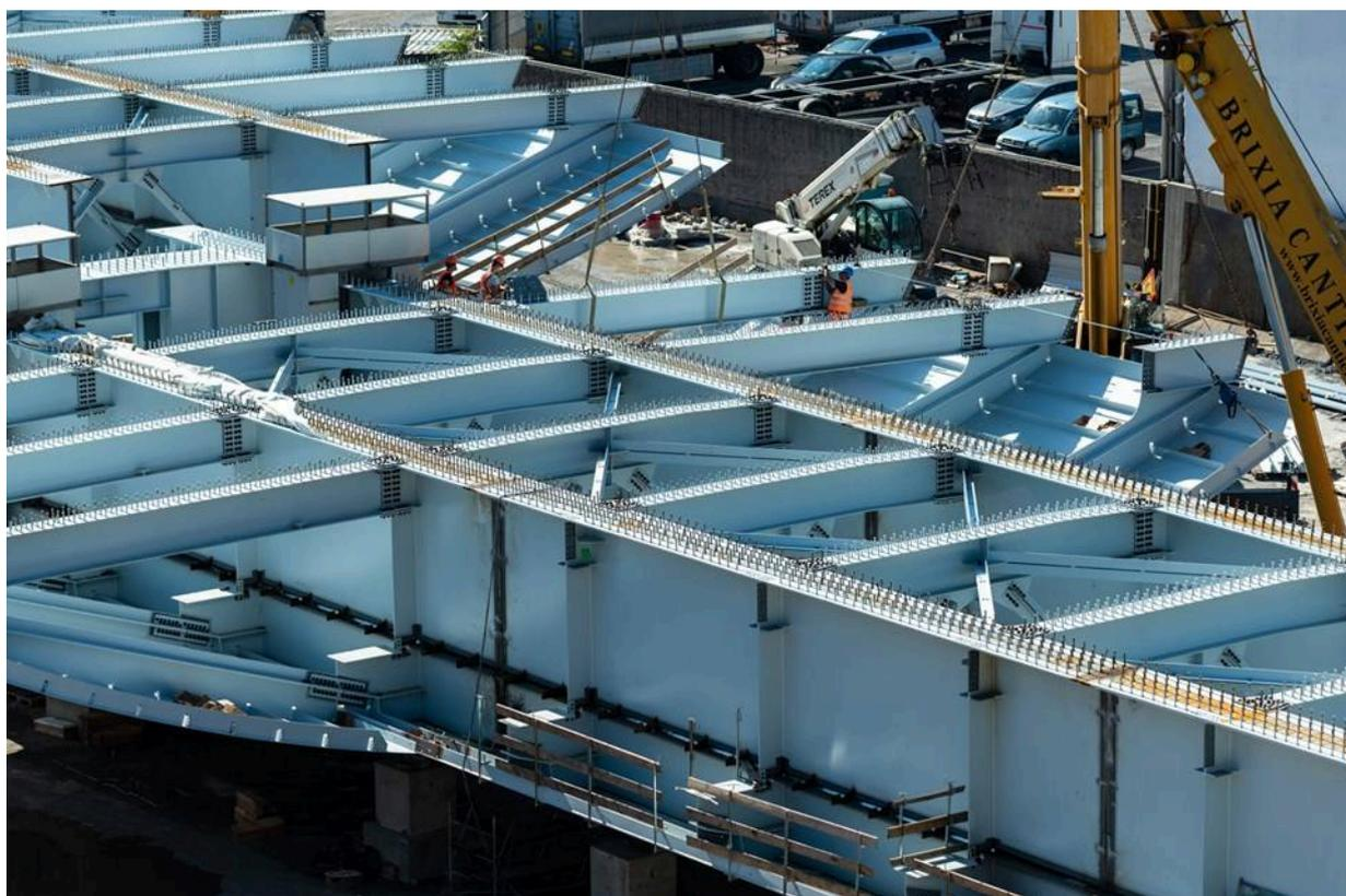
Per accelerare ulteriormente le operazioni di costruzione **entro fine mese è previsto l’ingresso in cantiere di una gru cingolata CC 6800**. **Al mondo esistono solo una decina** di esemplari. La gru è alta quasi 100 metri ed è in grado di sollevare 1250 tonnellate, da ferma, e servirà tra le altre cose per montare le campate da 100 metri, quella che scavalcherà il torrente Polcevera e quella che supererà il parco ferroviario del Campasso.
