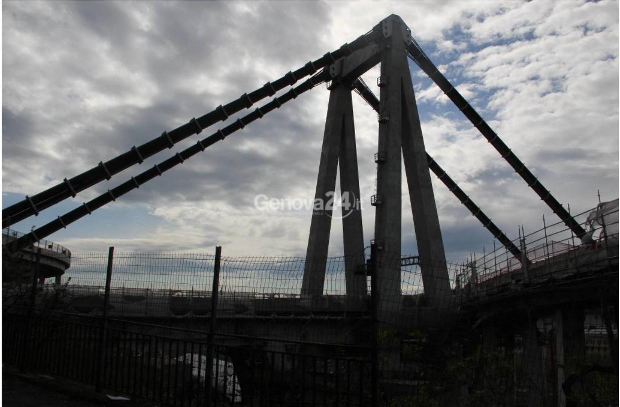
**Genova.** La struttura di Ponte Morandi ha iniziato a deformarsi in modo significativo dal 2015 e negli ultimi mesi di vita della struttura il movimento è aumentato.
