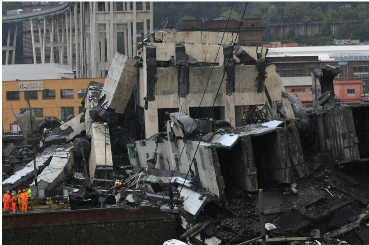
Nel 1992, a seguito di alcuni controlli si scopre che la pila 11 è fortemente ammalorata, con una perdita di capacità di carico di circa il 30%. Da qui i lavori di consolidamento della struttura che ha portato all'aggiunta di cavi esterni, in rinforzo degli stralli e della sella della pila. **Politicamente un mettere nero su bianco che qualcosa non andava, e che era meglio intervenire.** Finché era possibile farlo.
