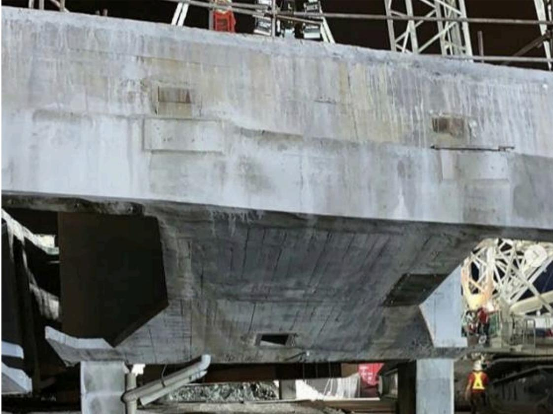
**Genova.** L'impalcato della pila 3 di ponte Morandi, al cantiere ovest, è stato completamente smontato. Anche l'ultima fetta è stata calata a terra con l'utilizzo delle potenti gru. P
