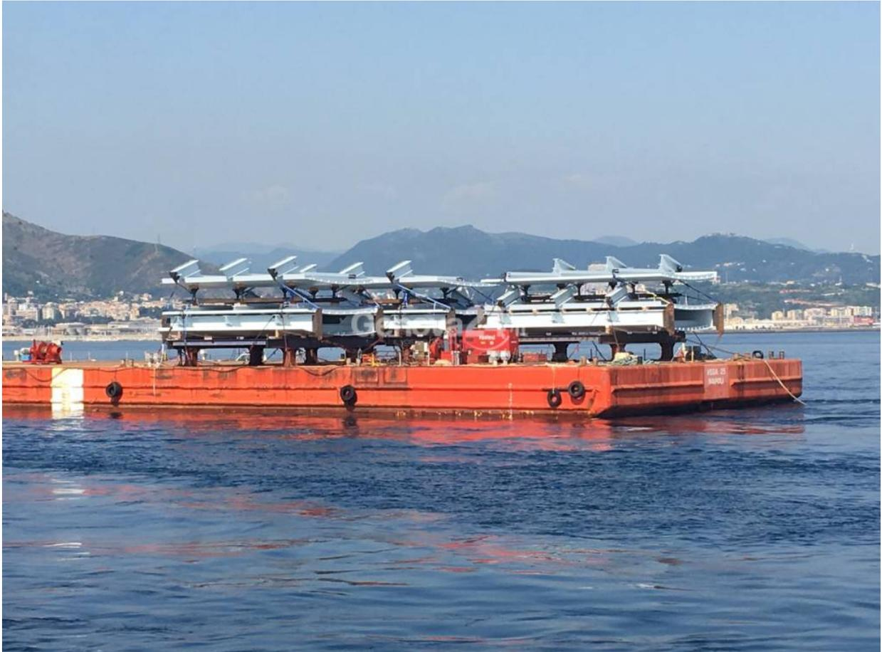
**Genova.** Da Castellammare a Genova trainato su una grande chiatta che, per 5 giorni di navigazione, ha trasportato gli elementi d'acciaio che, all'interno dello stabilimento Fincantieri di Genova Sestri Ponente, 'diventeranno' il primo impalcato del nuovo Ponte di Genova.
