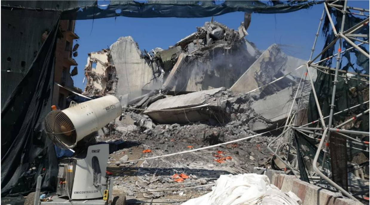
**Genova.** Le immagini mostrano in azione i cannon fog (nebulizzatori), dotati di un telecomando che permette la rotazione e il comando a distanza. Prodotti dalla Emicontrols di Bolzano, hanno una gittata che va dai 25 a 60 metri ed emettono fino a 6000 litri di acqua all'ora. Strumenti che sono in funzione da ieri, attivati immediatamente successivamente alla demolizione delle pile 10 e 11 per mitigare la dispersione di polveri.
