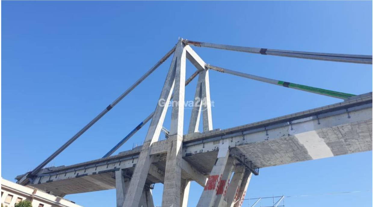
**Genova.** L'esplosione dei monconi di ponte Morandi verrà eseguita con particolari accorgimenti per consentire di arrecare meno danni possibili agli stralli che dalla cima delle pile sostengono le campate del ponte.
