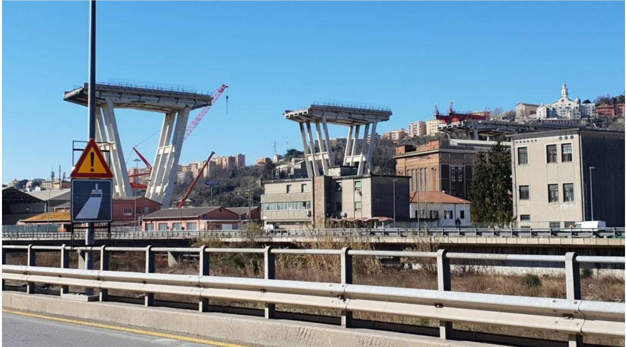
**Genova.** Potrebbero iniziare il 10 giugno e proseguire fino al 12 luglio le operazioni propedeutiche e quelle vere e proprie di demolizione, probabilmente con uso di esplosivo, delle pile 10 e 11, il moncone est di ponte Morandi.
