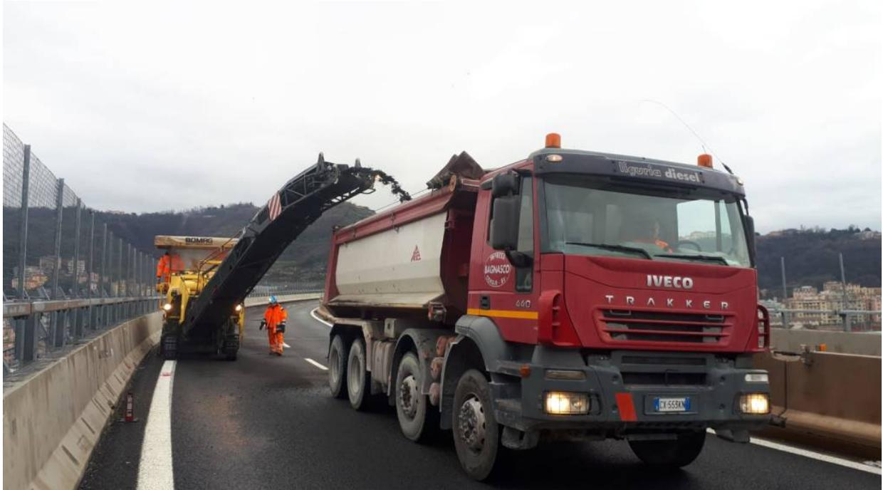
**Genova.** La pioggia di queste ore non ha ostacolato la prosecuzione delle opere propedeutiche alla demolizione di ponte Morandi. Le aziende che si stanno occupando dello smantellamento hanno iniziato oggi il lavoro di scarificazione dell'asfalto sull'impalcato del moncone ovest del viadotto Polcevera. Mezzi meccanici e un camion, e i relativi conducenti, sono saliti sul ponte.
