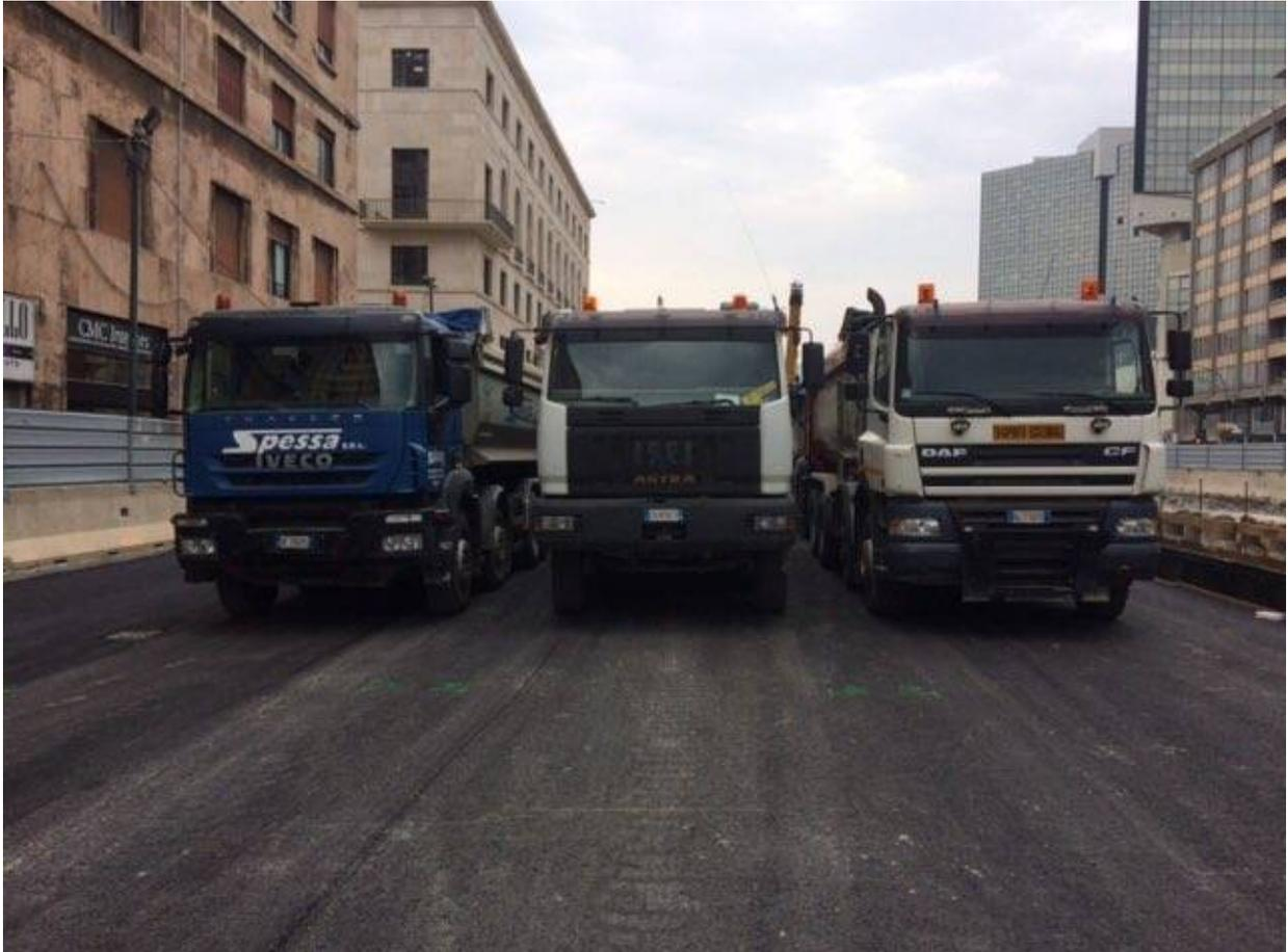
**Genova.** Più vicino il ritorno alla normalità, per il traffico nel quartiere della Foce. Il consorzio Itinera ha annunciato oggi, con un tweet, che è stato effettuato il collaudo con le prove di carico della soletta di copertura sul torrente Bisagno, in viale Brigate Bisagno.
