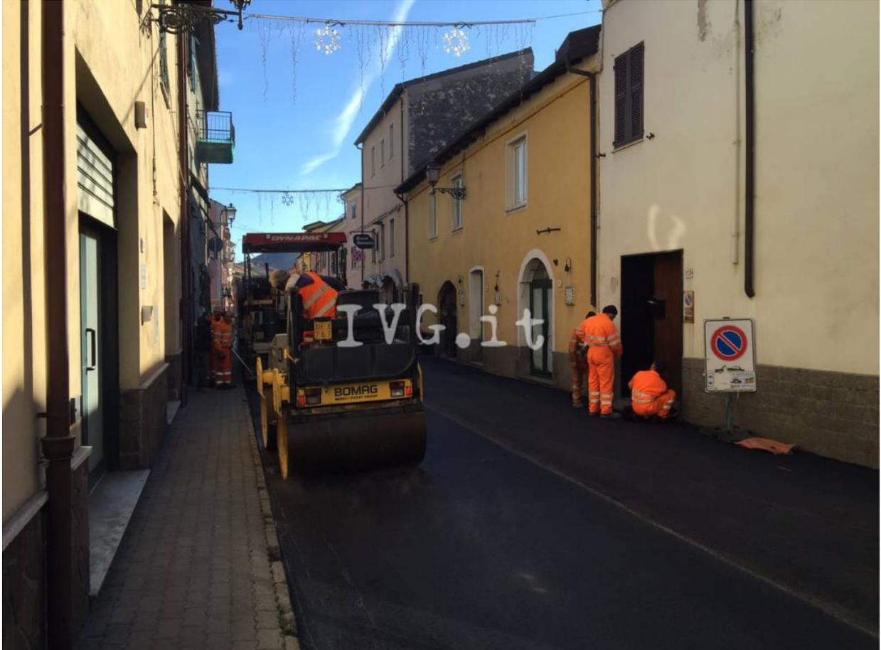
**Mezzanego e Borzonasca.** Senso unico alternato con semafori sulla SP26bis della Valmogliana per il ripristino della pavimentazione con nuove asfaltature fra i km. 2.650 e 3,700 della strada dopo la posa di condotte dell'acqua.
