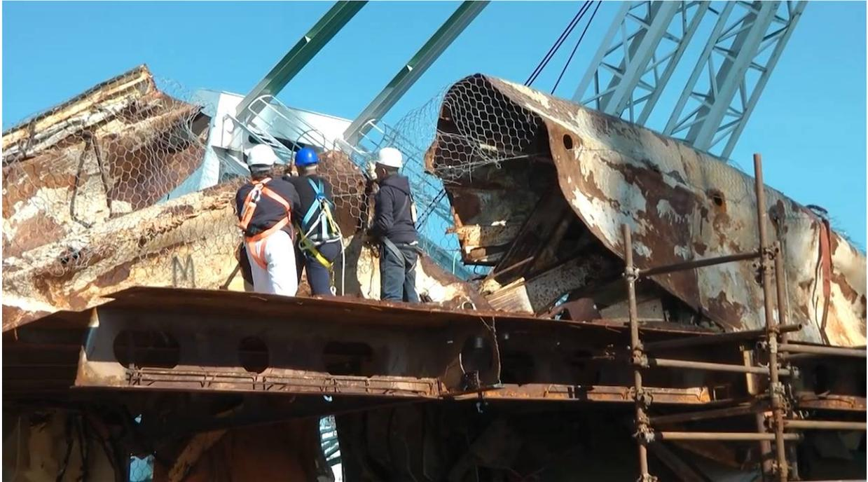
**Genova.** Emergerà nelle prossime settimane il ponte “zero” della Concordia che, attualmente, ha raggiunto un pescaggio di 13 metri, risultato delle attività di alleggerimento, ossia di rimozione degli allestimenti e delle strutture interne al relitto e di quelle di taglio e rimozione dei ponti.
