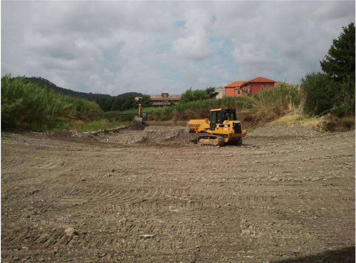
**Sestri Levante.** Proseguono i lavori di pulizia e manutenzione idraulico forestale nei rii e torrenti. Il Comune è intervenuto tagliando la vegetazione e regolarizzando il greto dell'alveo, spianando le zone di accumulo e di sedimentazione, con conseguente innalzamento del fondo alveo e riempimento delle zone in erosione in diversi tratti del torrente Gromolo, a valle del ponte di via Primi, ponte di via Vercelli, zona di Santa Vittoria e ancora a monte in zona Campomoneto.
