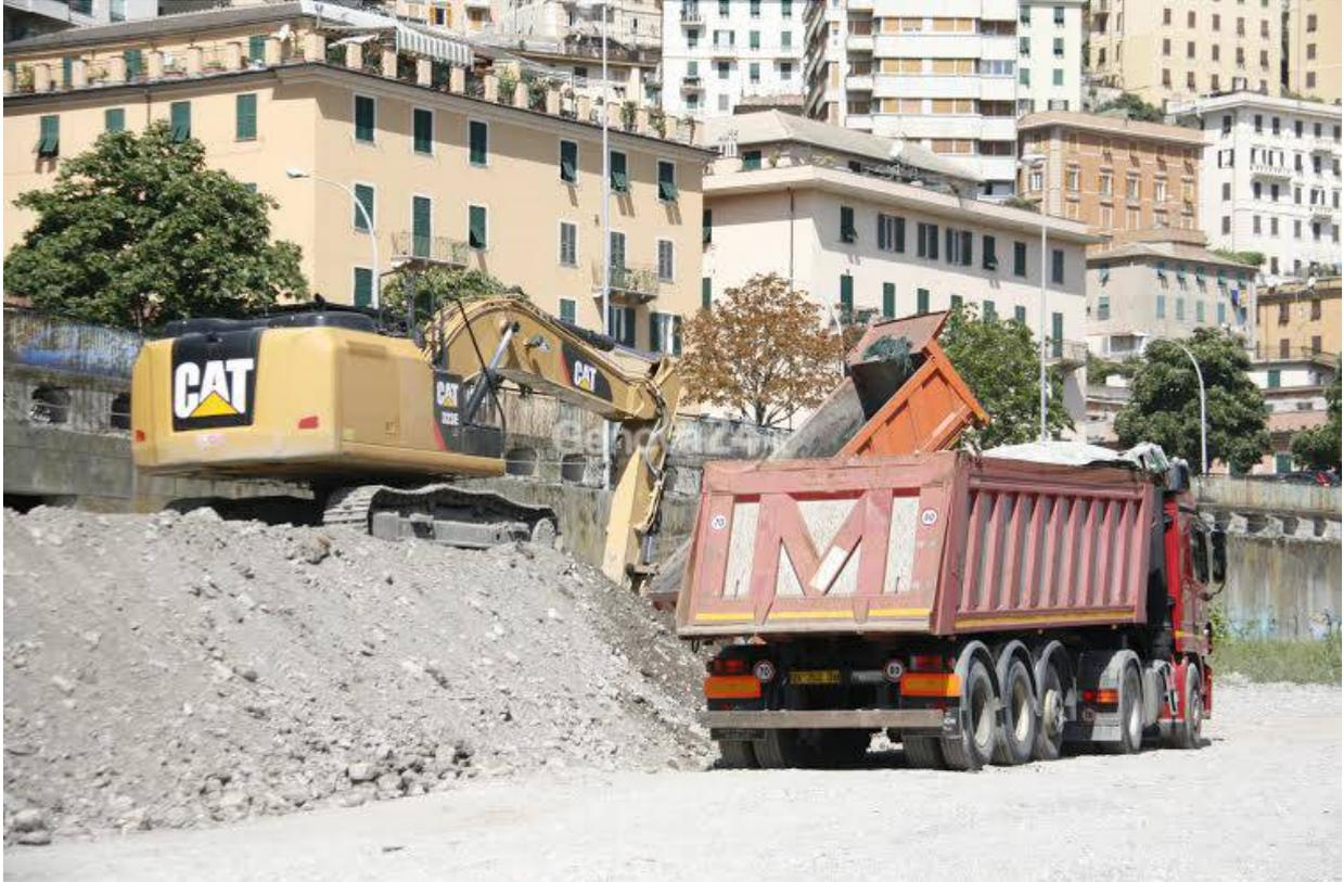
**Genova.** Proseguono gli interventi nel torrente Bisagno. Dopo aver terminato i lavori di riprofilatura del tratto dell'alveo all'altezza di Borgo Incrociati, con la rimozione di 972 metri cubi di terra e il conferimento ad Amiu di un cassone di masserizie varie e un autocarro di materiali ferrosi, sono iniziati i lavori per l'eliminazione del materiale di sovralluvionamento presente nel fornice della sponda centro-sinistra all'altezza di Marassi.
