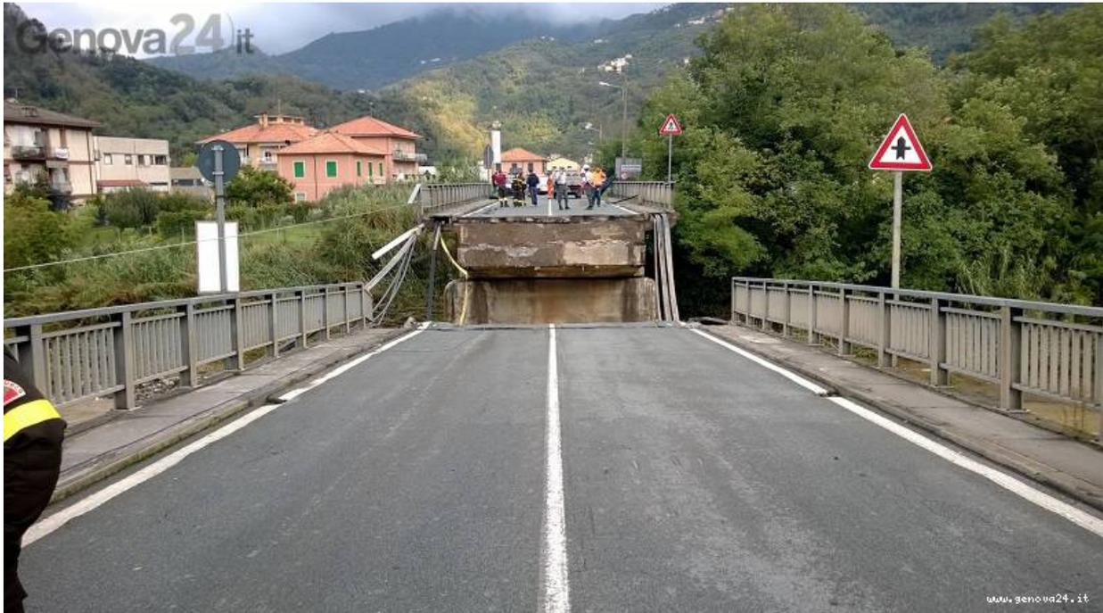
**Carasco.** Continuano senza sosta i lavori per ricostruire il ponte di Carasco, crollato nella tragica alluvione del 21 e 22 ottobre scorsi. Il nuovo attraversamento scavalcherà lo Sturla con 300 tonnellate d'acciaio per restituire alla Fontanabuona il suo collegamento più importante con la costa del Tigullio.
