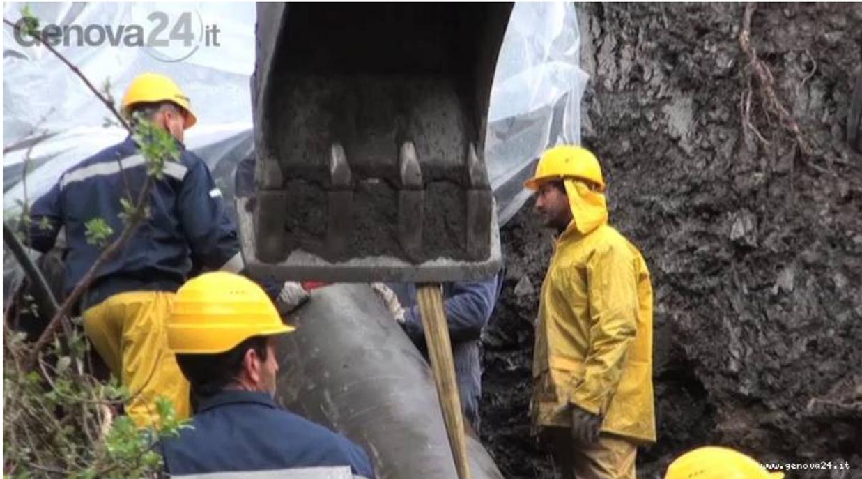
**Genova.** Agg ore 16.40: Sta piovendo forte a Serra Riccò ma i tecnici Snam sono riusciti a far "accoppiare" i due tubi ed è iniziato da poco l'intervento di saldatura. Dopo i tubi dovranno essere raffreddati e dovrà essere fatta una radiografia della condotta saldata. Poi se tutto andrà bene ci sarà il collaudo e l'agognato via libera per la riapertura del manodotto e, di seguito, lo stop all'ordinanza del Comune di Genova che vieta l'uso di riscaldamento e acqua calda.
